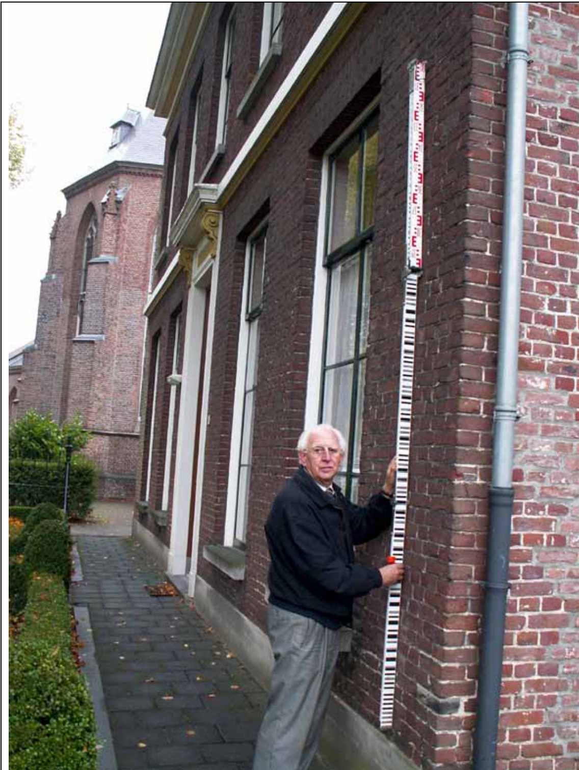
Figuur 7.3-7 Jo Versteijnen plaatst de peilstok op de NAP-bout in de voorgevel van de pastorie
