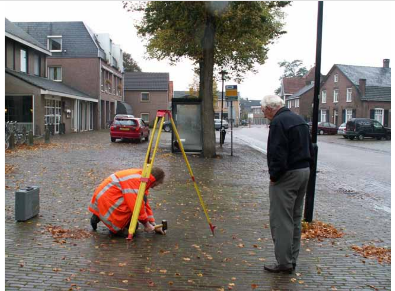
Figuur 7.3-8 Aanbrengen van merkteken in plaveisel van Marktplein.
