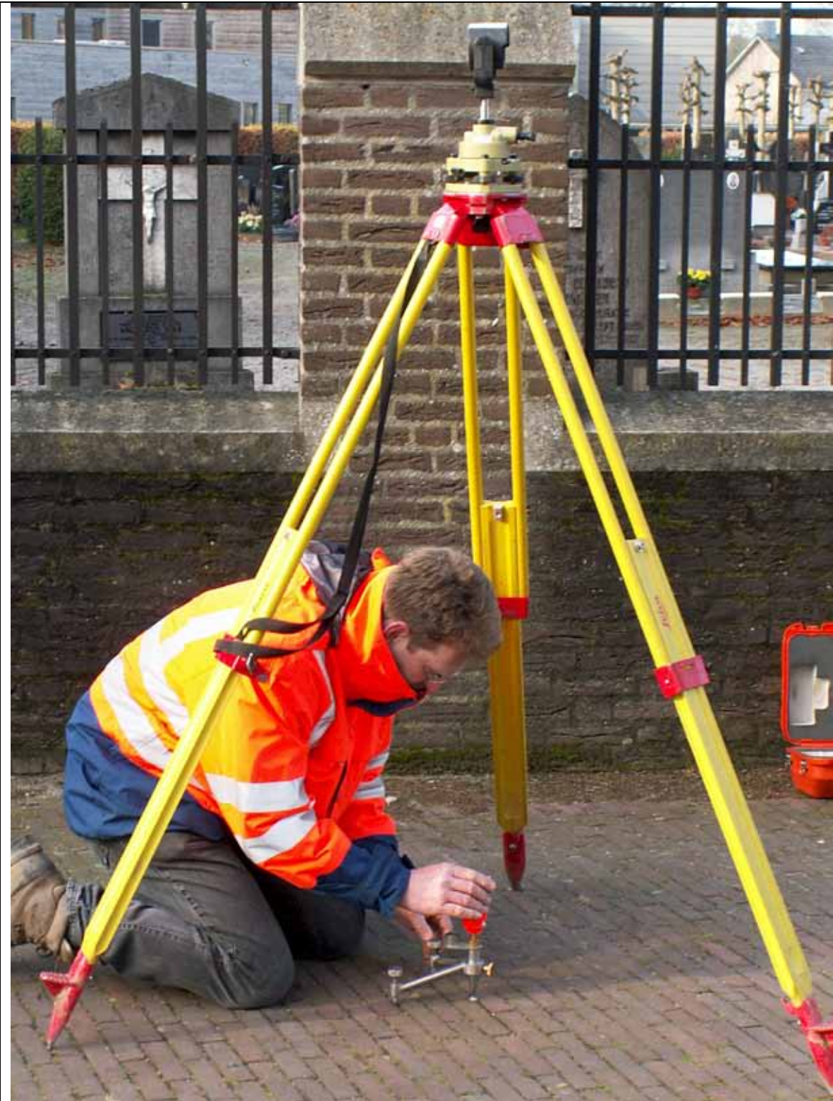
Figuur 7.3-6 Peter Linders plaatst reflector op markering in plaveisel
